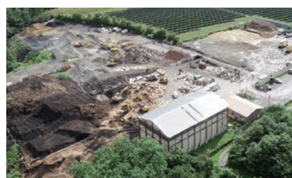
六戸センター／工事部
